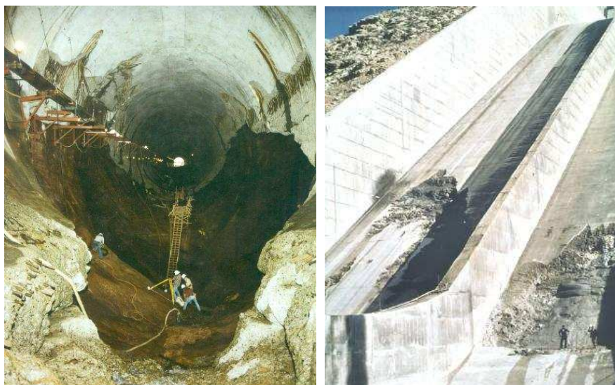
شکل (۱): خسارات کاویتاسیون در سرریز سد کارون I (سمت راست) و تونل تخلیه کننده تحتانی سد گلن کانین (سمت چپ).
