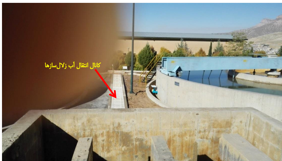
تصویر ۹: زلال‌سازها و کانال انتقال آب زلال در تصفیه‌خانه آب شهر ایلام
