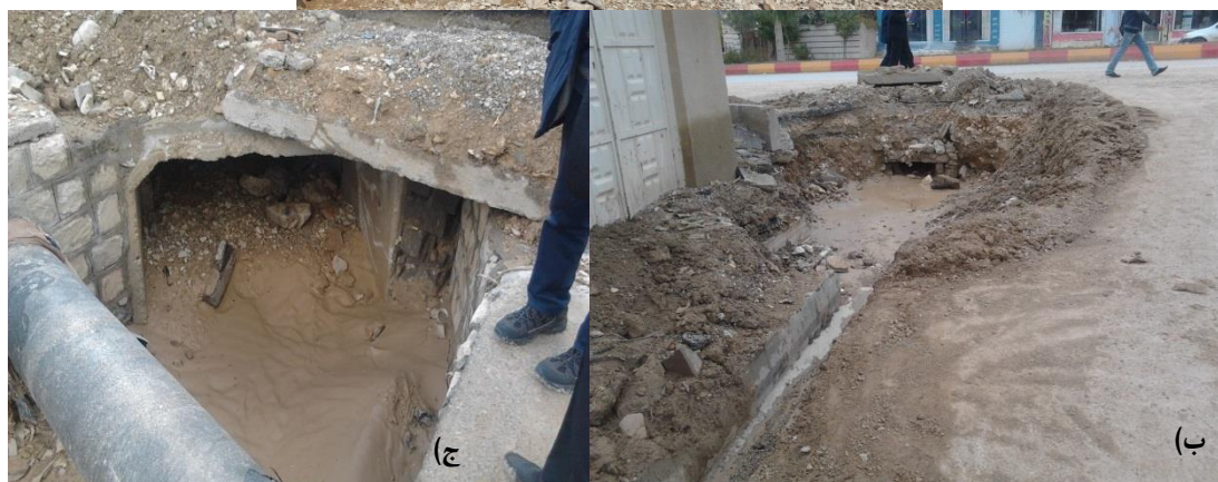
تصویر ۵ الف) ساخت و ساز در حریم مسیل (محله پیچ آشوری-مسیر گلزار شهدا) ب) اتصال ناصحیح جداول سطحی به مسیل اصلی (بلوار اصناف) ج) طراحی نامناسب و ظرفیت پایین آبگذری (بلوار نماز)
