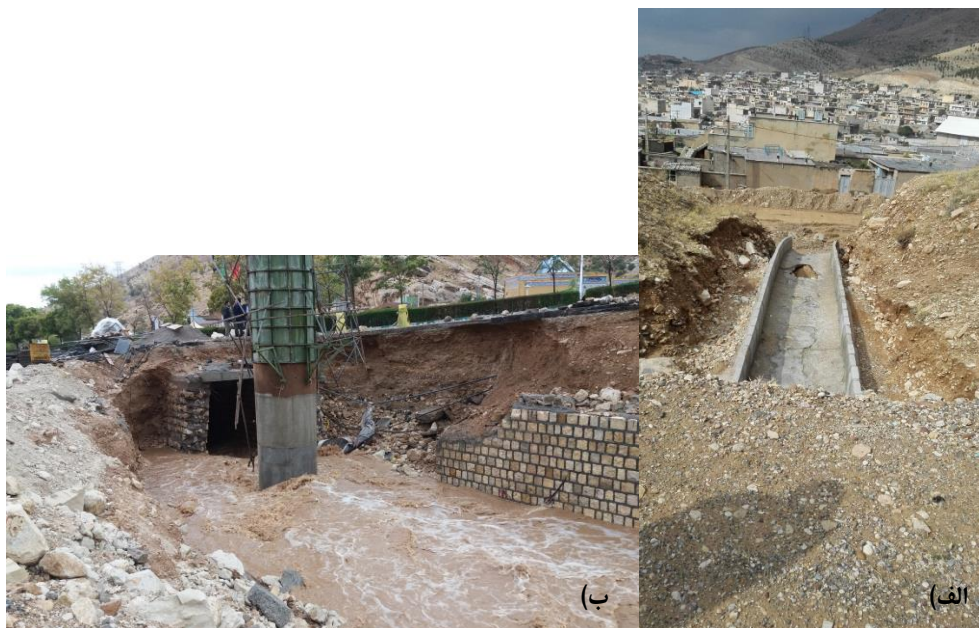
تصویر ۴ الف) مسیل متقاطع با جاده کمربندی شرقی (ساماندهی ناقص و رهاسازی در منطقه مسکونی) ب) احداث پایه پل روگذر ارغوان روبروی ورودی مسیل (ساخت و ساز در حریم)
