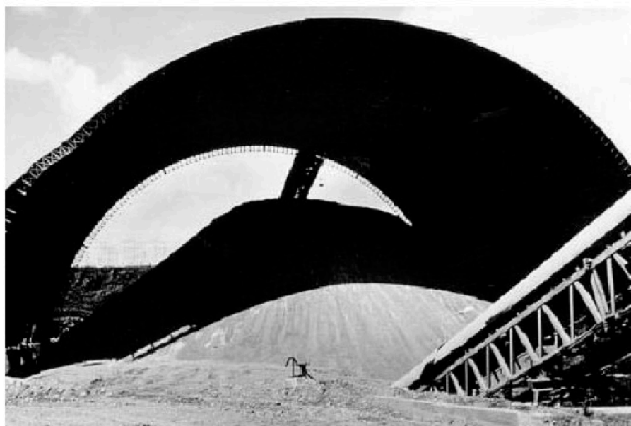
شکل ۱- دپو سنگدانه ها زیر سایبان
